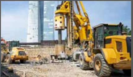
04. Großdrehbohrgeräte und Rammen
